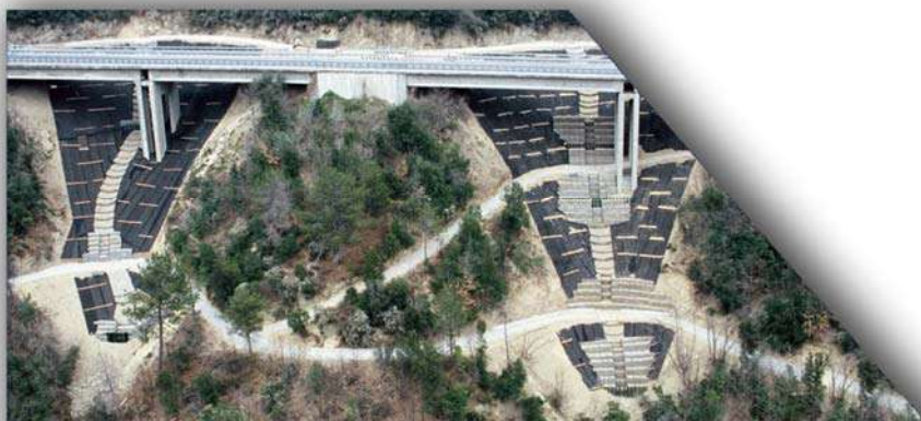
SISTEMAZIONI IDROGEOLOGICHE: VIADOTTI AUTOSTRADA TORINO SAVONA
