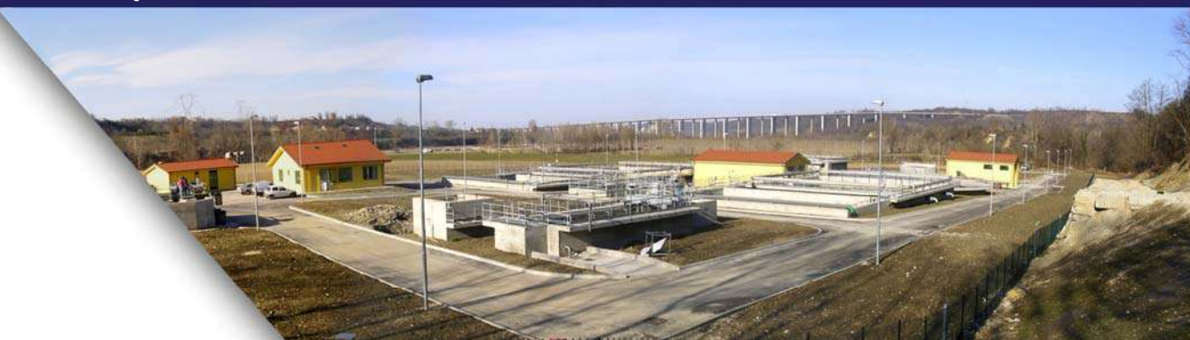
IMPIANTO DI DEPURAZIONE FOSSANO
